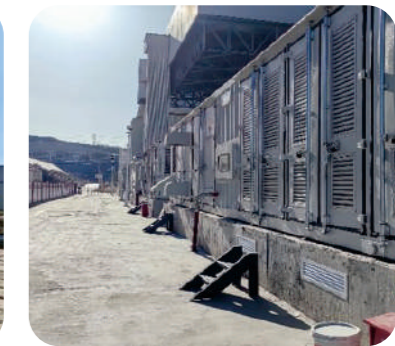
新元洁能电石厂调峰项目
