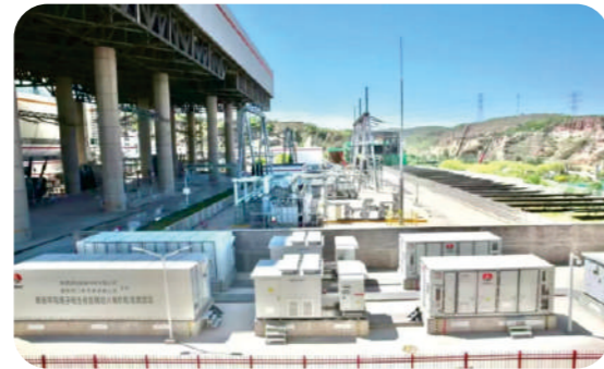
西北首套高功率锂电池+钠离子电池混合调频系统
