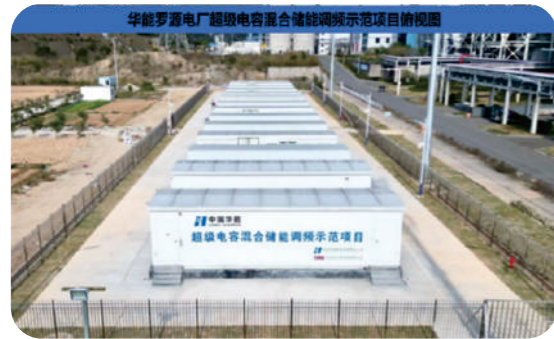
全国首套高功率锂电池+超级电容混合辅助调频系统
